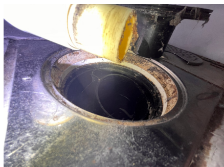
Ikke synlig slukmansjett
