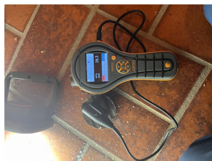
Målt på bakside av panel i vegg mot grunnmur.
