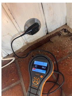
Målt i veggpanel mot grunnmur.
