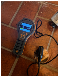
Målt på bakside av panel i vegg mot dusjsone.
