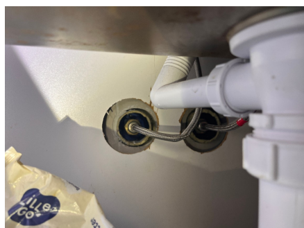
Rørgjennomføringer i vegg
