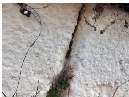
Isopor på utside av grunnmur.
