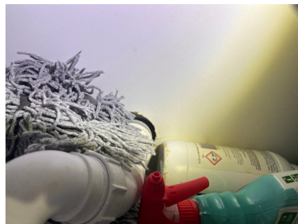
Rørgjennomføringer i vegg
