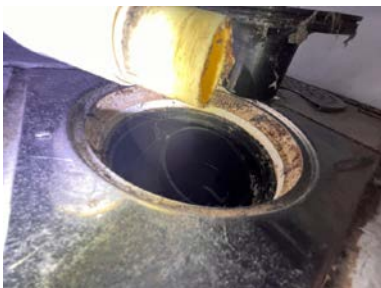
Ikke synlig slukmansjett
