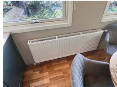
Radiator i kjøkken
