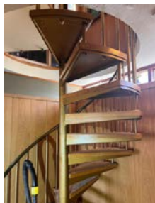
For store åpninger mellom trinn
