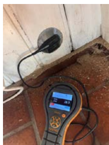
Målt i veggpanel mot grunnmur.
