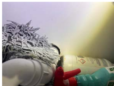
Rørgjennomføringer i vegg
