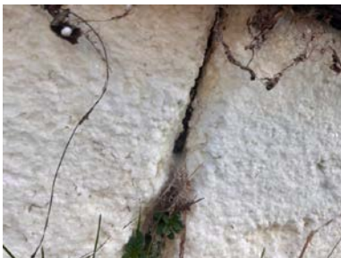
Isopor på utside av grunnmur.
