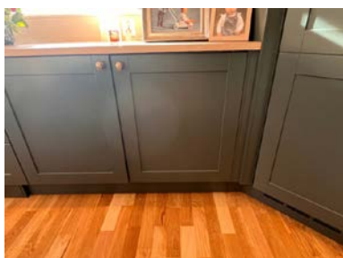
Ikke montert luft rist under fryseskapet
