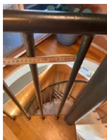
For store åpninger mellom trinn
