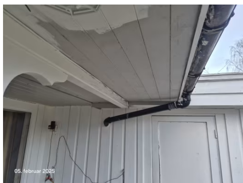
Nedløp føres inn i vegg.
