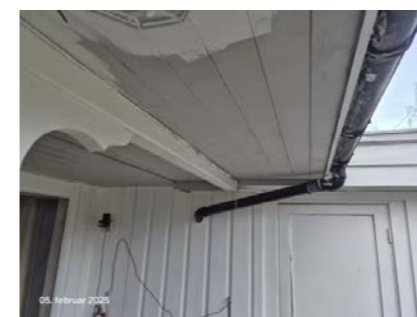
Nedløp føres inn i vegg.
