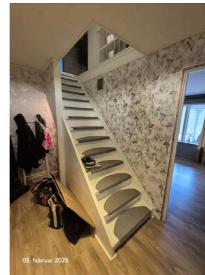
Håndløper og rekkverk mangler.
