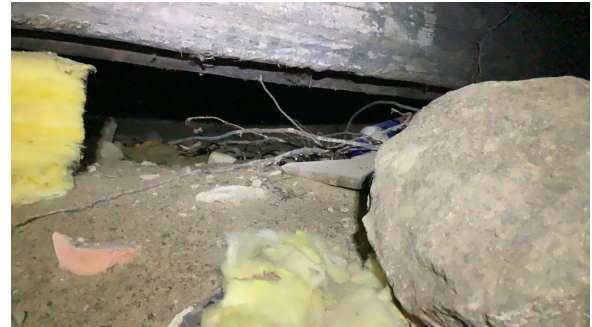
Lav adkomst til krypkjeller under hall.
