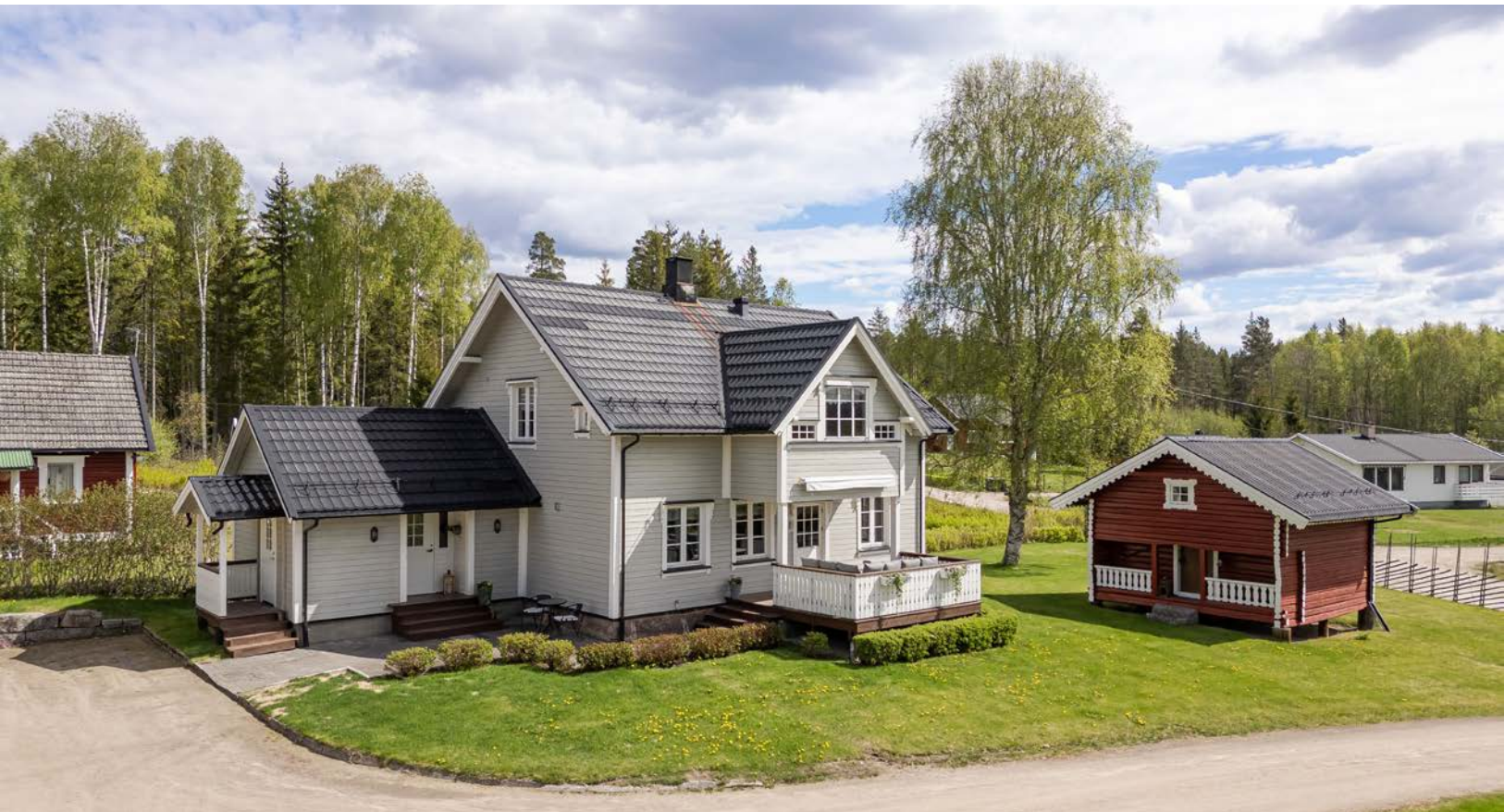
Veggene er utvendig kledd med liggende bordkledning, oppgradert med etterisolering i 2007.
