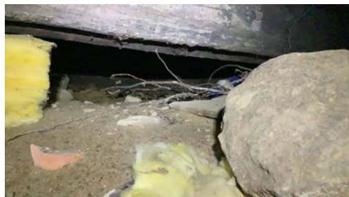
Lav adkomst til krypkjeller under hall.
