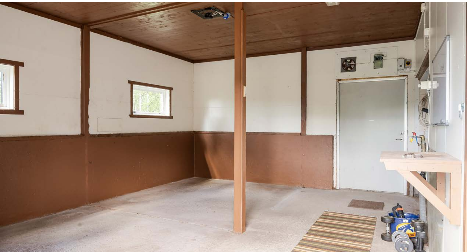
Stallinredning er fjernet, men stallrom har murt brystning på tre vegger og mekanisk avtrekk via vifter. Utstysrom har i dag innedel for hundegård og god plass til lagring av mindre utstyr.
