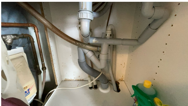
Besiktigelse av røropplegg.
