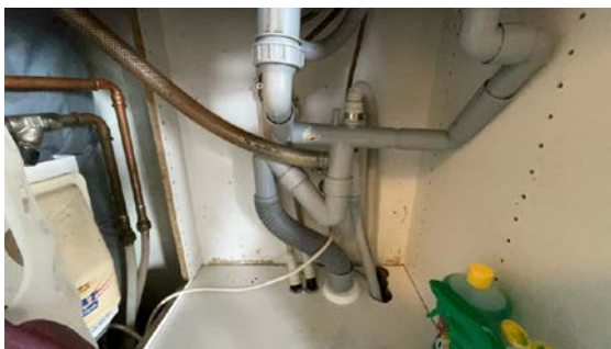
Besiktigelse av rørøpplegg.
