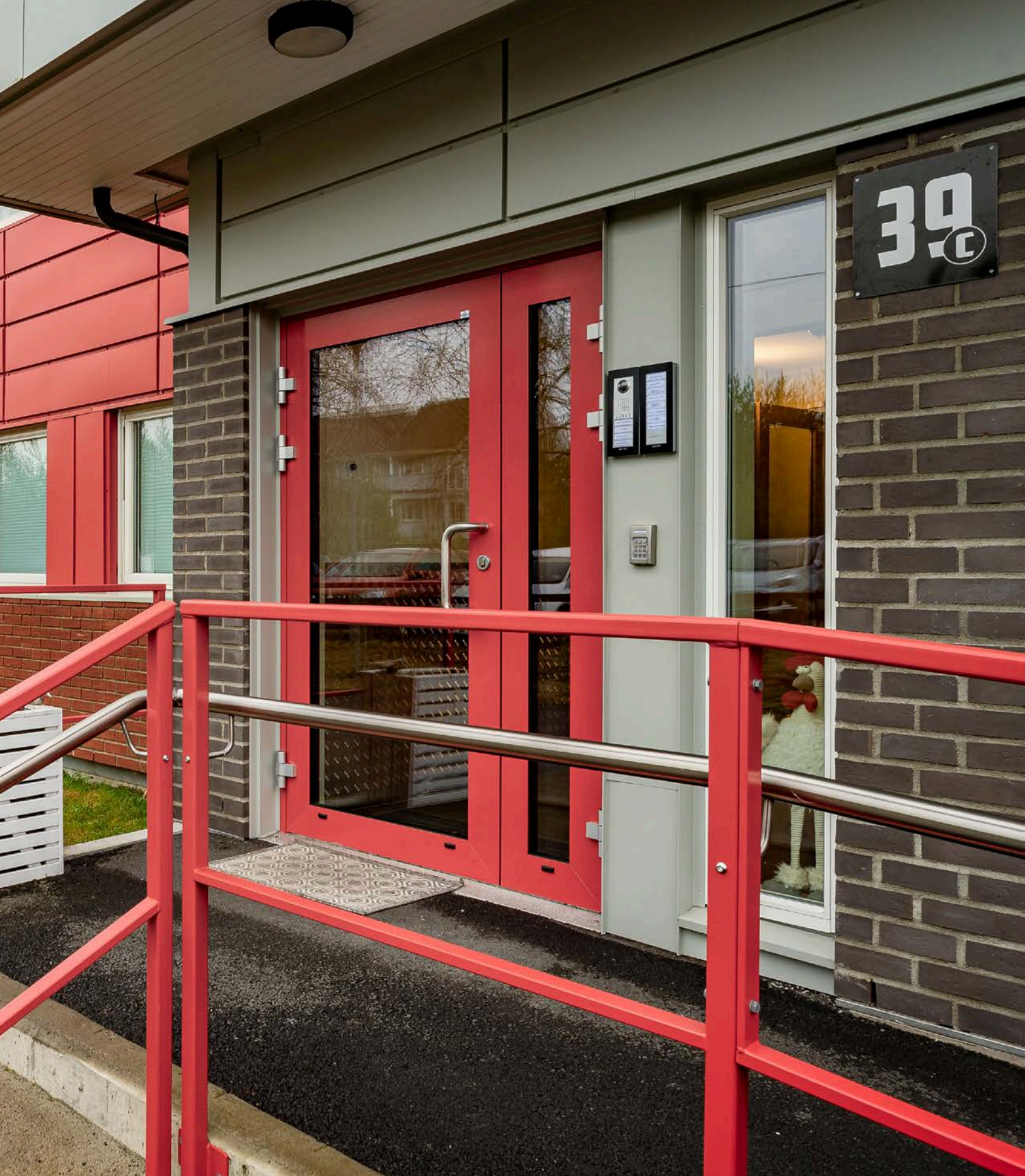
Overbygget inngangsparti inn til felles trapperom med heis opp til leiligheten som ligger i byggets toppetasje (4. etasje).
