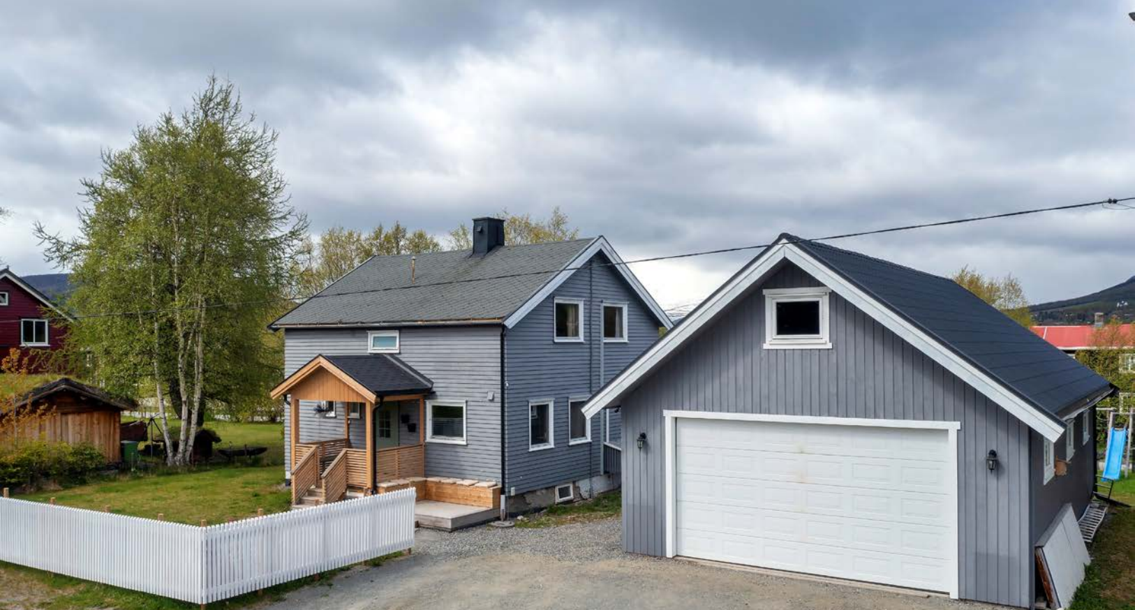
Eiendommen er bebygd med enebolig oppført i 1955 og garasje oppført i 2007
