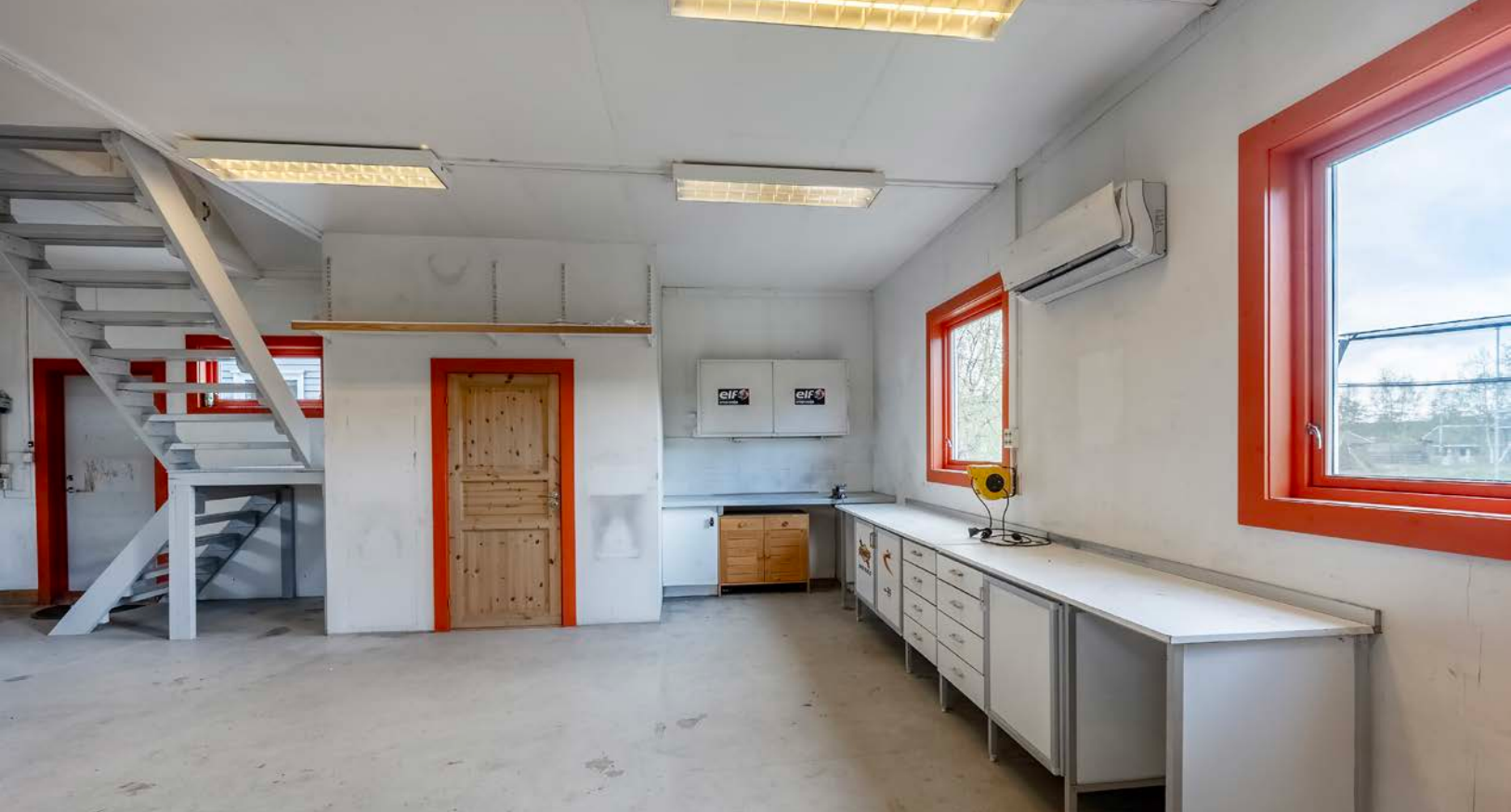
Garasjens 1. etasje er isolert og det er montert varmepumpe
