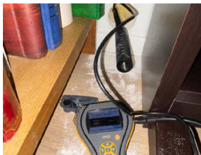
Fuktmåling i vegg ved hulltaking.
