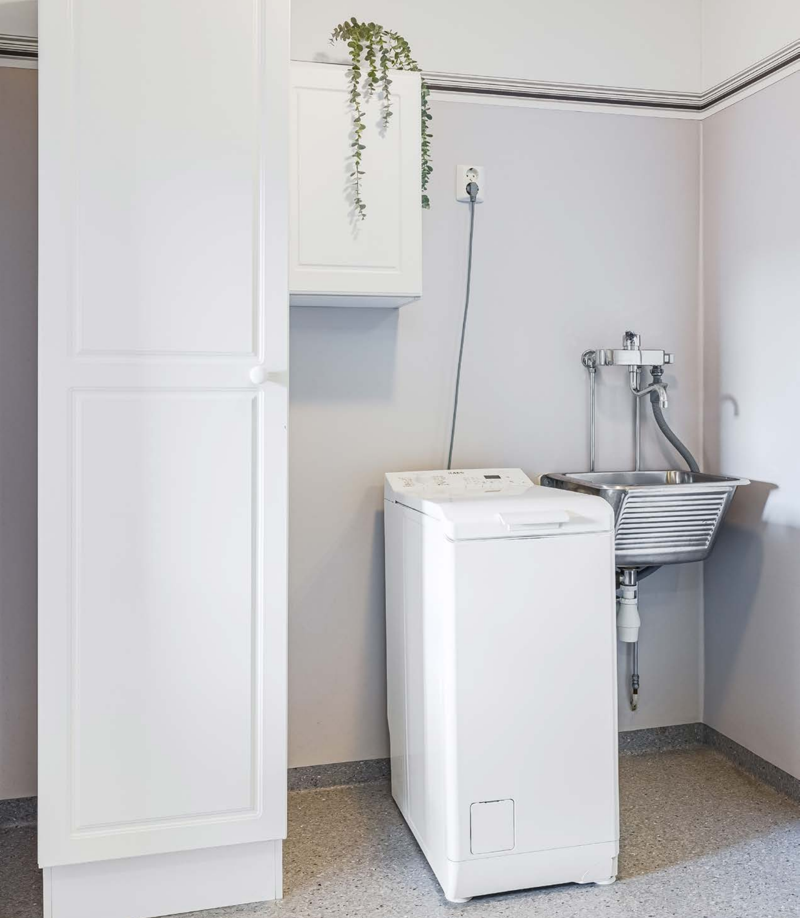
Det er opplegg til vaskemaskin på badet, utslagsvask og høyskap for ekstra oppbevaring.
