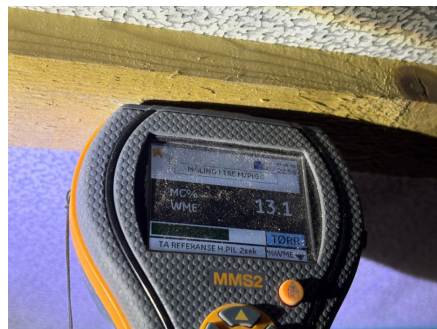
Ingen forhøyede fuktverdier i konstruksjonen
