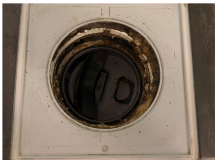
Plastsluk uten tegn på skader
