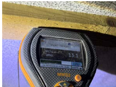
Ingen forhøyede fuktverdier i konstruksjonen
