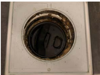
Plastsluk uten tegn på skader
