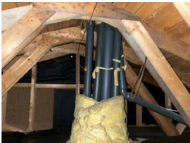
Mange uisolerte rør på loft. Ukjent hva dette er.
