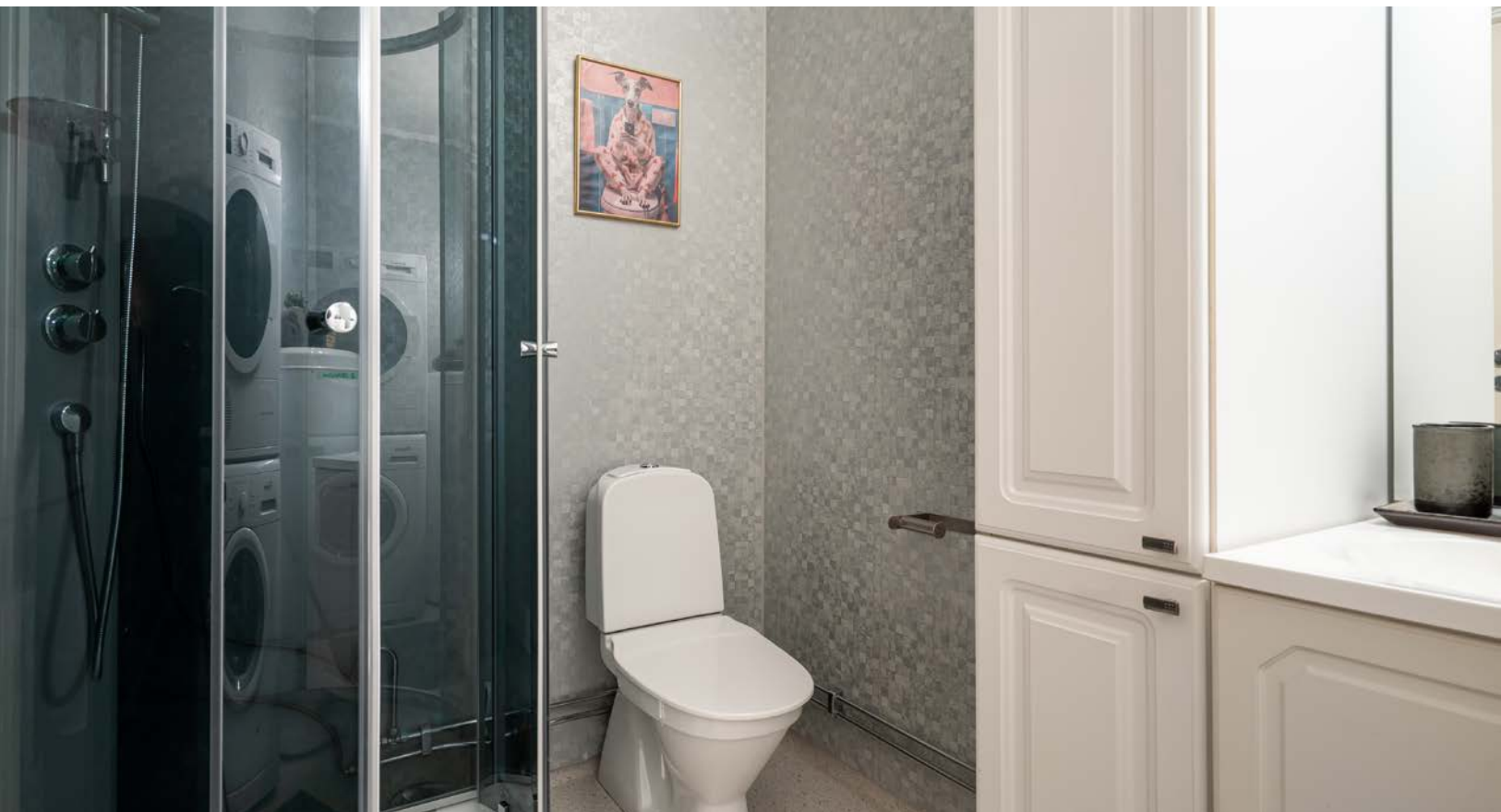
Det er gulvvarme på bad.
