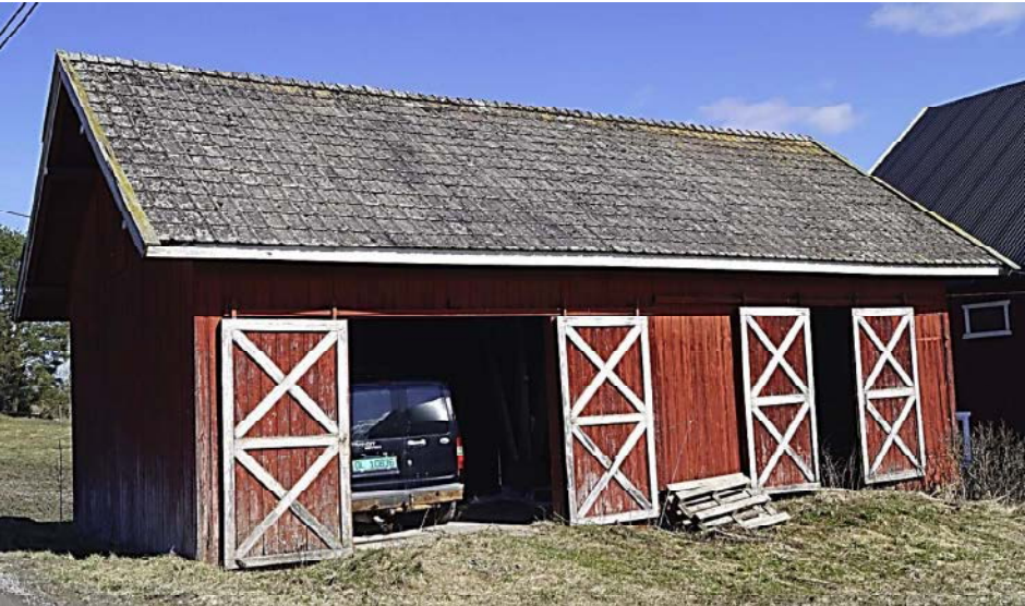
Bildet viser vognskjulet sett fra tunet
