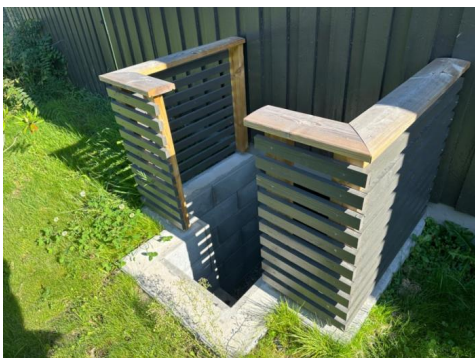
Rekkverk rundt lyskasser.
