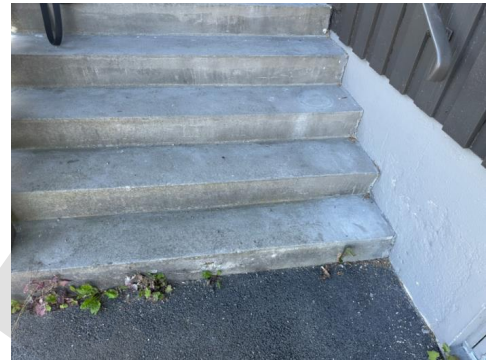
Trapp til inngang.
