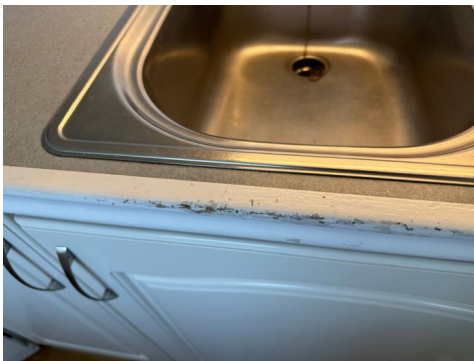
Slitasje i front på benkeplate.
