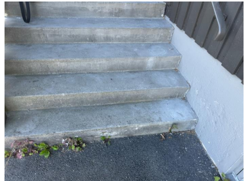
Trapp til inngang.
