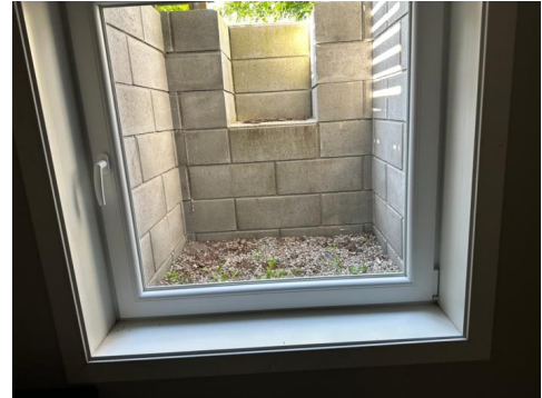
PVC vinduer og lyskasse på utsiden.
