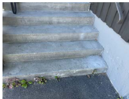
Trapp til inngang.
