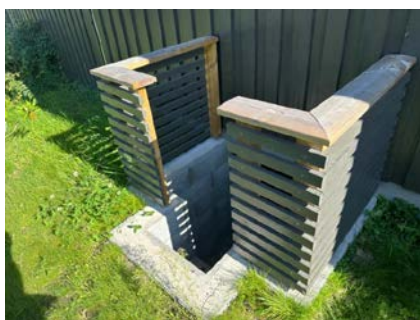
Rekkverk rundt lyskasser.
