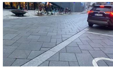
Figur 20: Bilde illustrerer hvordan samme type dekke kan benyttes for å skille mellom ulike brukssoner i trinnfrie områder. Bilde tatt utenfor Herbarium i Stavanger.
