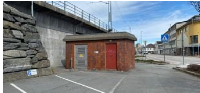
Figur 15: Dagens situasjon ved pumpe- og trafostasjon i Jernbaneveien, sett nordover mot Strandgata.
