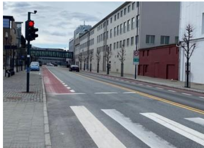
Figur 5: Dagens situasjon av Elvegata.
