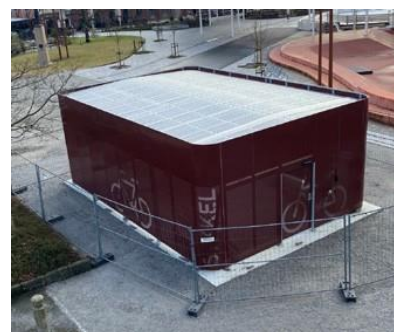
Figur 24: 3D Sykkelhotellet på Ruten er under oppføring. Bilde viser hvordan det ser ut pr. februar 2022.
