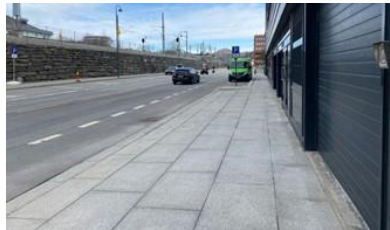
Figur 11: Bildet viser dagens granittdekke i gangsonene langs Jernbaneveien ved Tinghuset i Sandnes sentrum.
