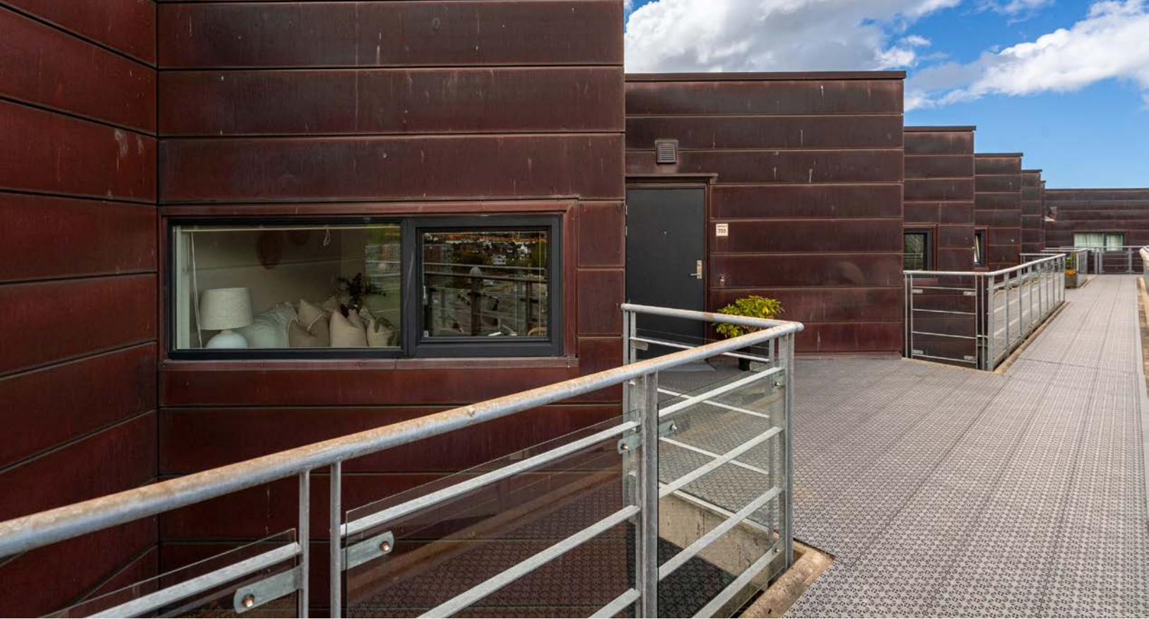
Inngangsparti. Det er parkering i lukket anlegg og heis
