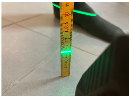
Måling på topp flis ved dørterskel.
