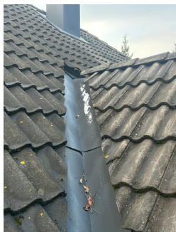
Beslag med symptomer på slitasje og elde.
