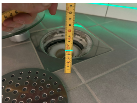
Måling av fall utenfor dusjsone.
