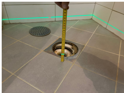
Måling av lokalfall i dusjsone.
