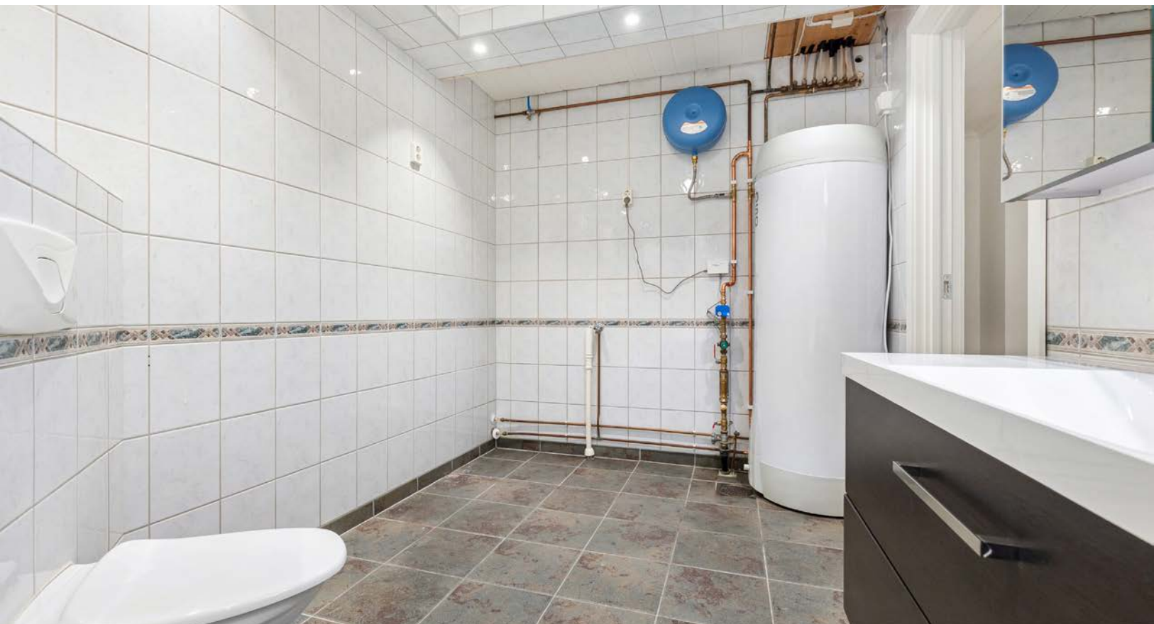
Bad er fra byggeår, oppgradert i 2024 med nytt servantskap, speilskap, armaturer, ny MDF panel i himling og byttede downlights. Det er opplegg for vaskemaskin.
