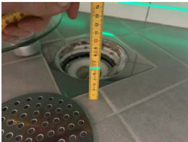
Måling av fall utenfor dusjsone.
