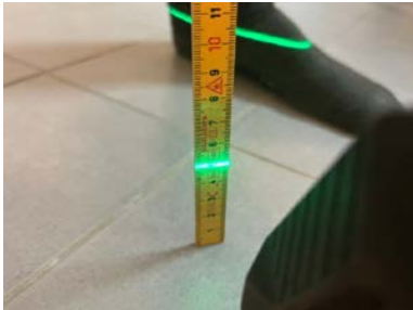
Måling på topp flis ved dørterskel.
