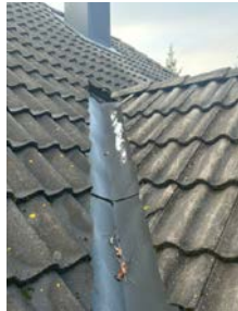
Beslag med symptomer på slitasje og elde.
