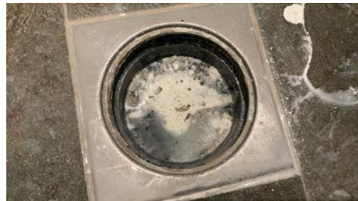
Sluk i dusjsone.
