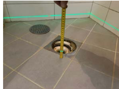
Måling av lokalfall i dusjsone.
