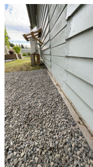
Lav høyde mellom grunnen og kledning, risiko for skader. Anbefalt høyde mellom terreng og kledning er 30 cm.
