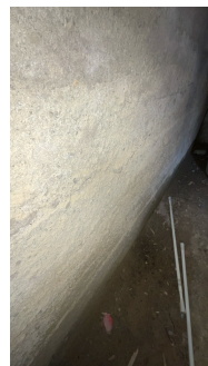
Det er påvist indikasjoner på noe fuktgjennomtrenging inn i kjellermur.
