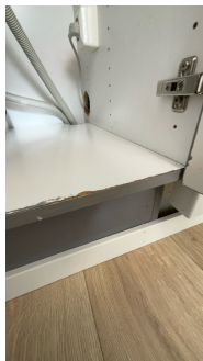
Fuktskjolder/svelling i bunnplate i benkeskap.
