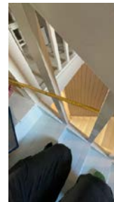
Åpninger i rekkverk er større enn dagens forskriftskrav til rekkverk i trapper.
