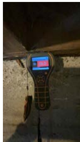
Ved enkel fuktmåling registrerte jeg skadelig fukt.
