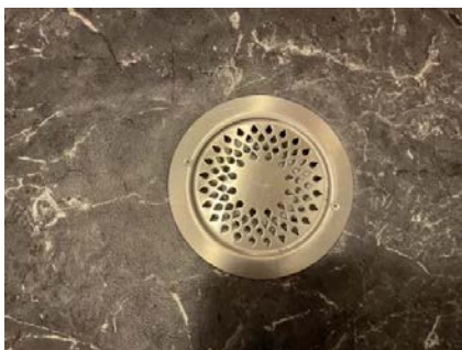
Sluk i teknisk rom.
