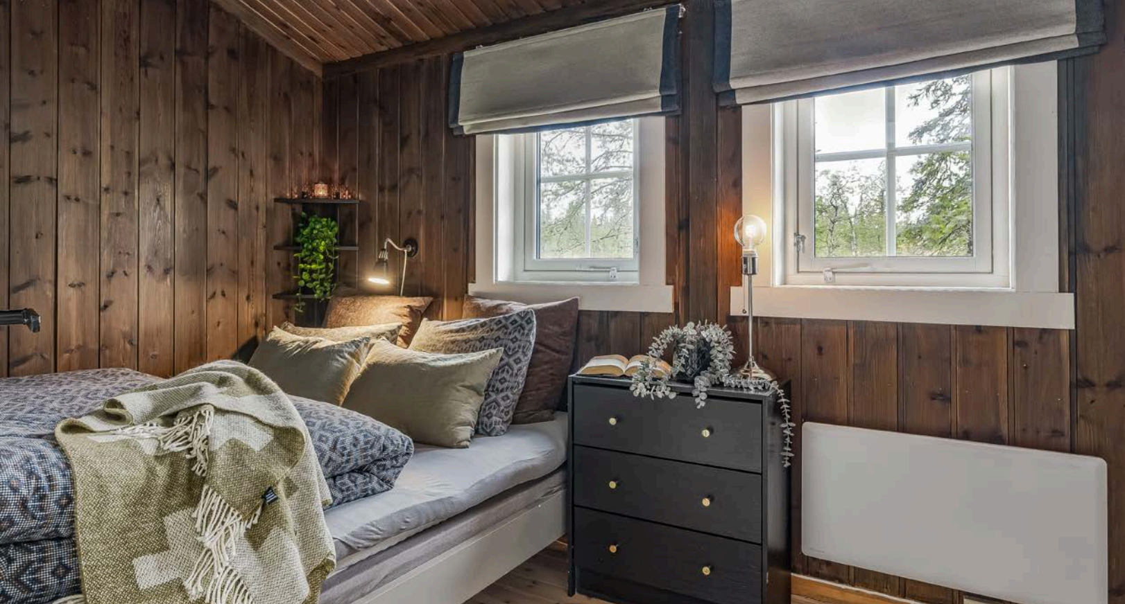
Soverom 2 har trepanel på vegger og tak, som gir et naturlig preg. Vinduene er nylig skiftet i 2024, og har trelags glass for god isolasjon.
