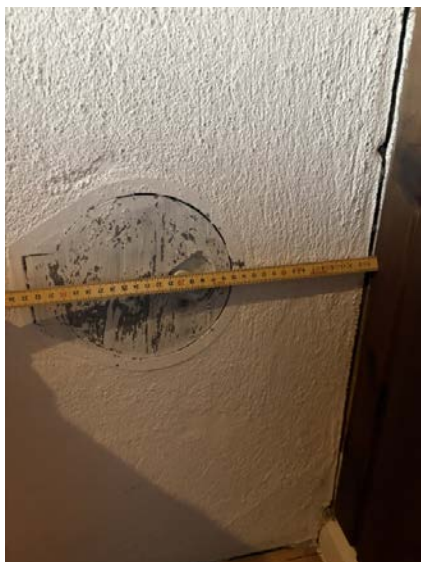
Kort avstand fra sotluke til brennbart.
