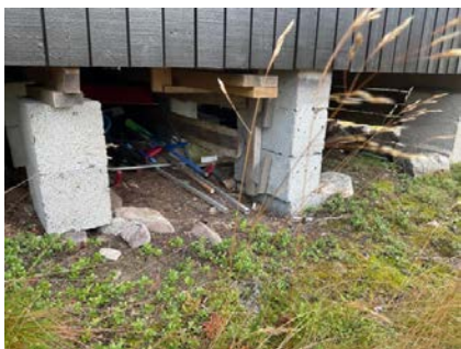
Fundament til terrasse.
