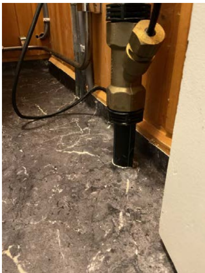
Gjennomføringer i gulv.
