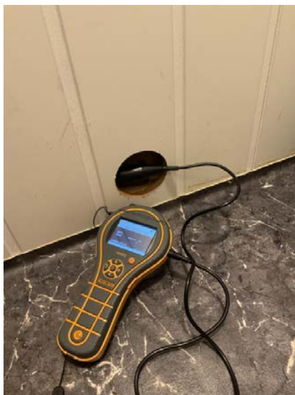
Hulltaking i tilstøtende rom.
