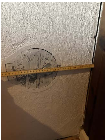
Kort avstand fra sotluke til brennbart.
