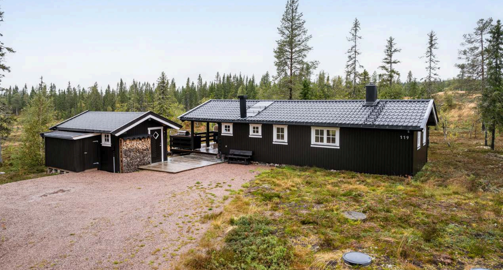
Fritidsboligen har en saltakskonstruksjon tekket med stålplater og er utstyrt med takrenner av metall.
