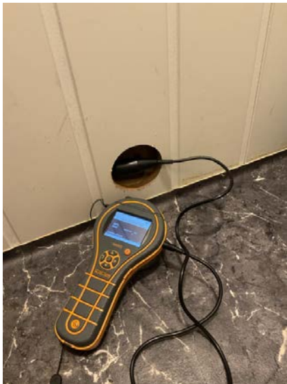
Hulltaking i tilstøtende rom.
