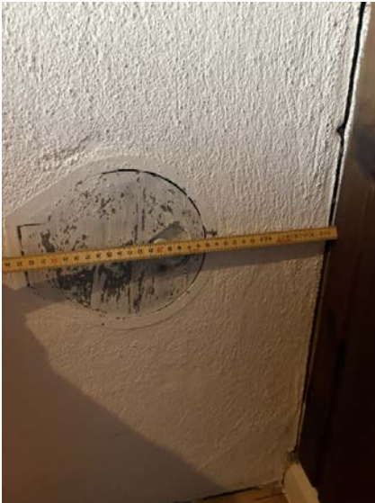
Kort avstand fra sotluke til brennbart.
