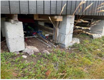
Fundament til terrasse.
