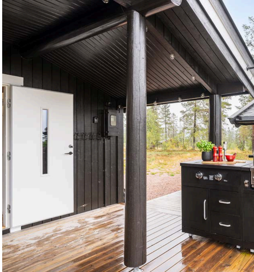
Tilngang via dels overbygget terrasse av tre med rekkverk og utekjøkken.
