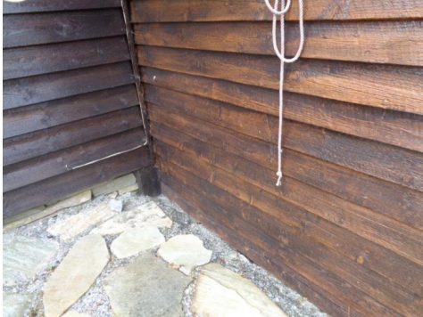
Bordkledning under dekke på uteplass.
