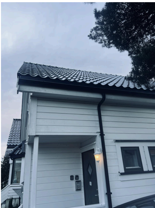
Glasert takstein. Det er ikke monter snøfangere.
