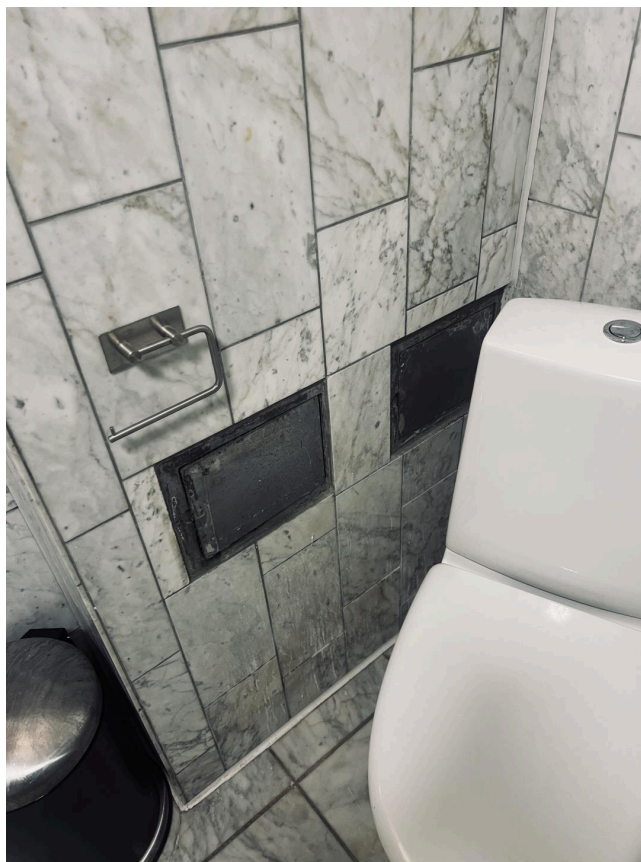
Feieluker i bad i 1. etg.
