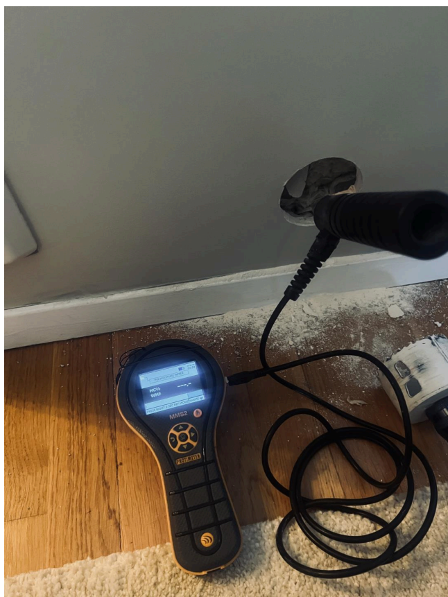
Hulltaking med fuktmåling.
