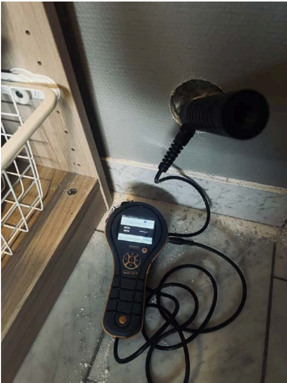
Fuktmåling bad 1. etg.
