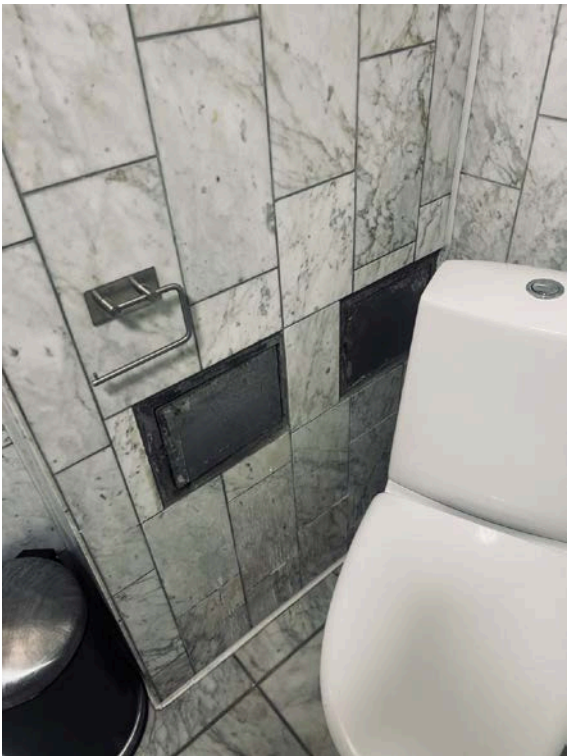
Feieluker i bad i 1. etg.
