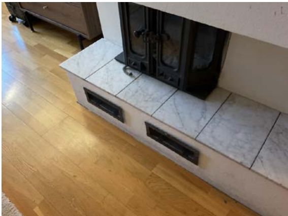
Mangelnde gnistplate på gulv.
