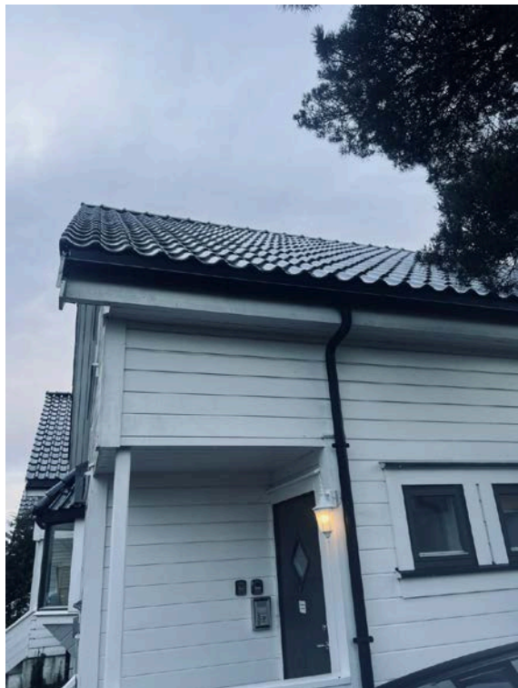
Glasert takstein. Det er ikke monter snøfangere.
