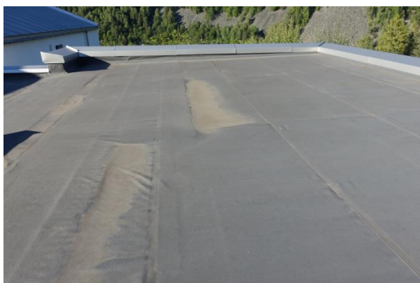
Taktekke garasje/teknisk rom.
