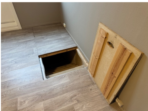
trapp til underliggende etasje
