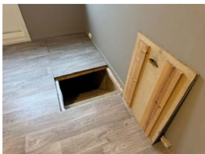
trapp til underliggende etasje
