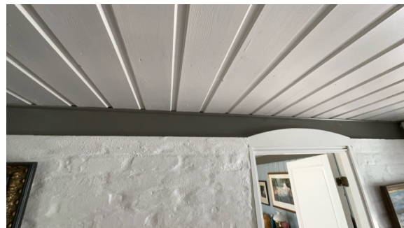
Del av vegg - tak.
