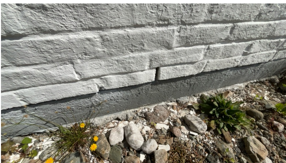
Del av grunnmur - støpt plate på mark.
