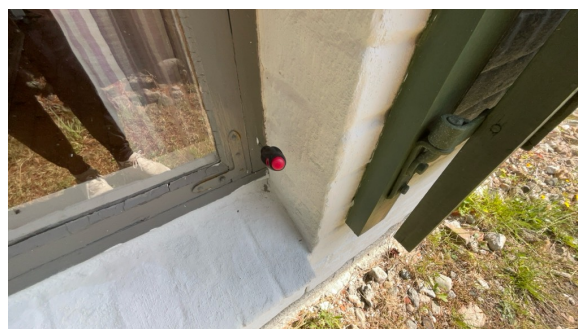
Stikk kontroll på vinduer er utført.
