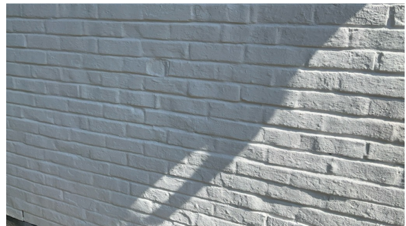
Del av vegg.
