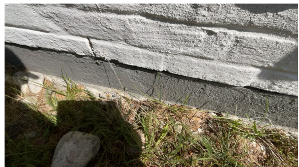
Del av grunnmur - støpt plate på mark.
