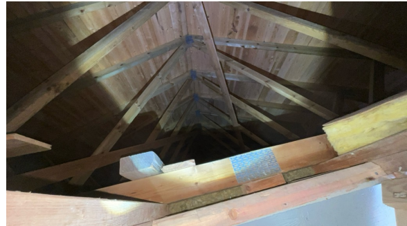
Del av takkonstruksjon, sett fra loft.
