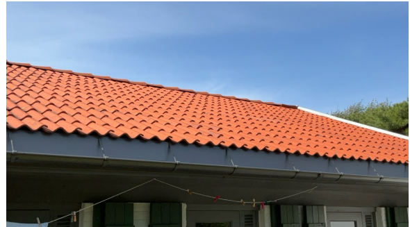
Del av taktekking.
