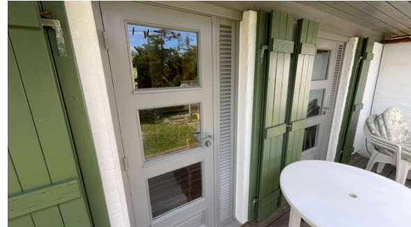
Eksempel på montert ventil i dør felt.
