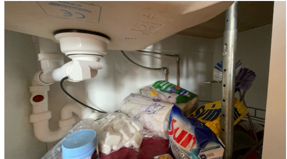
Del av rør til vann.
