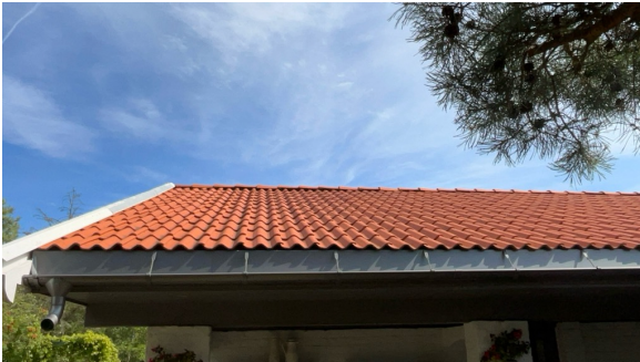
Del av taktekking.
