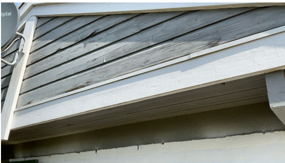
Del av vegg.
