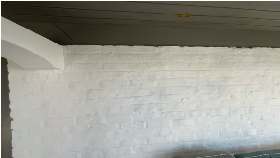
Del av vegg.
