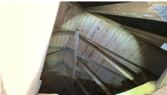
Del av takkonstruksjon, sett fra loft.
