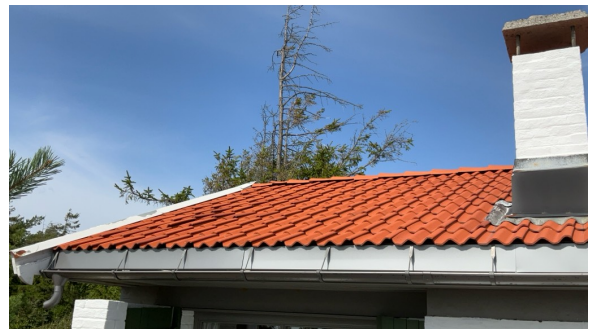
Del av taktekking.
