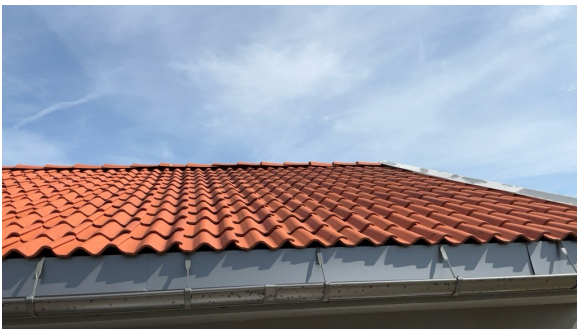
Del av taktekking.
