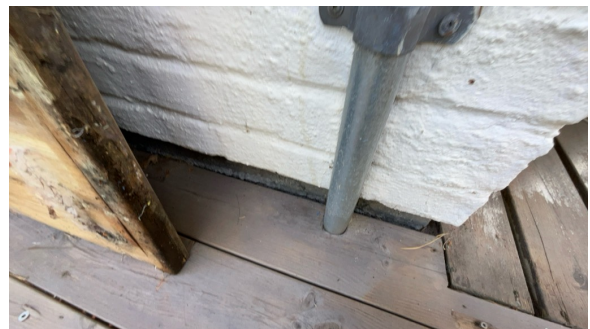
Del av grunnmur - støpt plate på mark.
