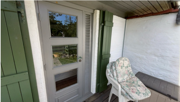
Eksempel på montert ventil i dør felt.
