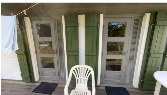
Terrassedører inn til soverom.
