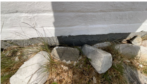
Del av grunnmur - støpt plate på mark.
