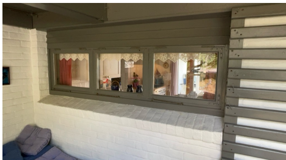
Eksempel på vindu i yttervegg.
