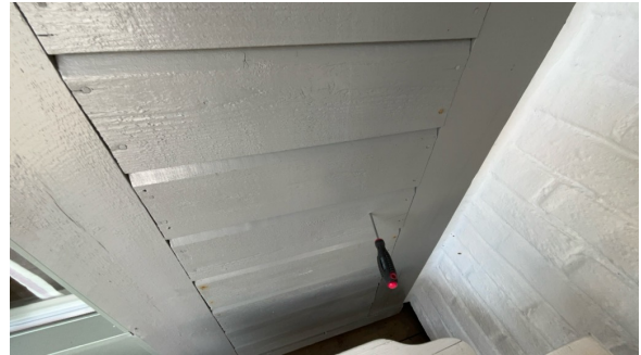
Stikk kontroll av vegger er utført.
