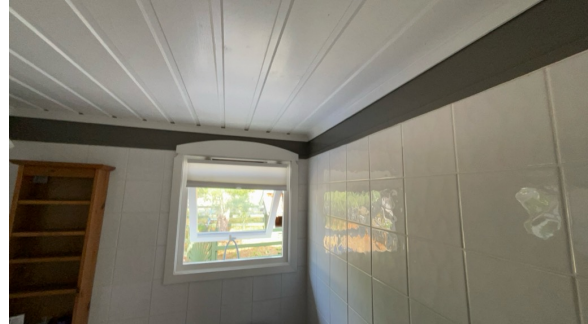
Del av vegg - tak.
