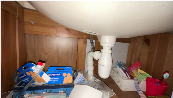
Del av rør til vann.
