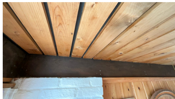
Del av vegg - tak.
