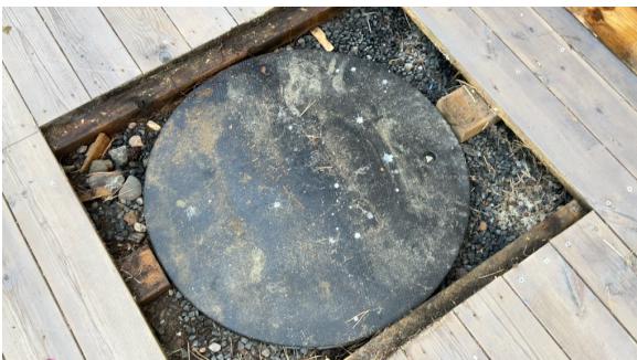
Tank med kværnepumpe.
