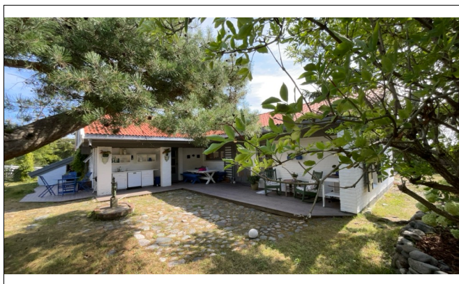
Hovedhytte oppført på eiendommen.
