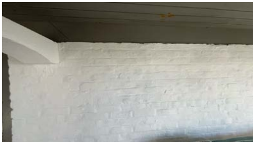
Del av vegg.
