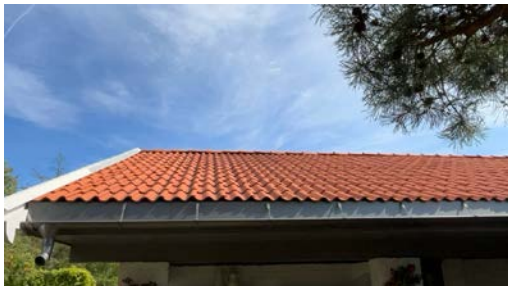
Del av taktekking.
