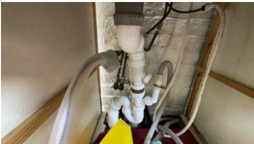
Del av rør til vann.
