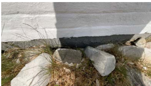
Del av grunnmur - støpt plate på mark.
