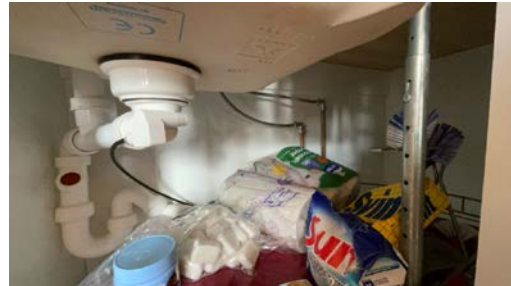
Del av rør til vann.
