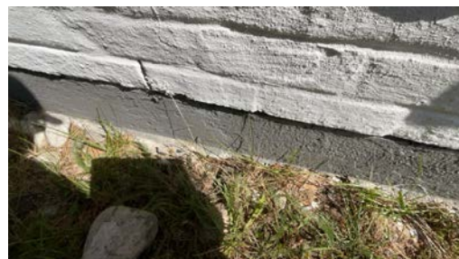
Del av grunnmur - støpt plate på mark.
