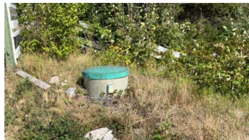
Septiktank som er tett og krever tømming etter forbruk.
