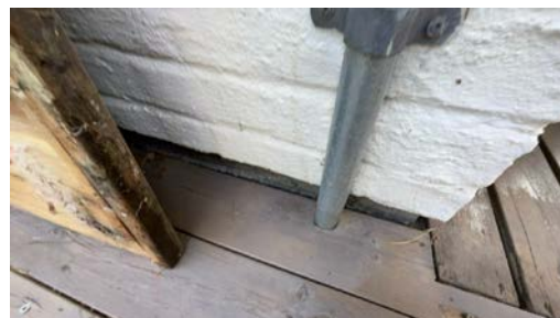
Del av grunnmur - støpt plate på mark.
