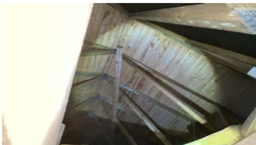
Del av takkonstruksjon, sett fra loft.
