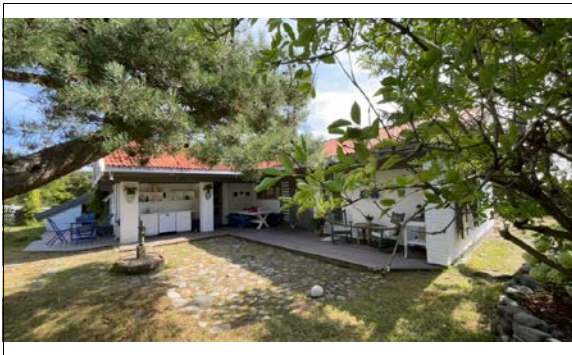
Hovedhytte oppført på eiendommen.
