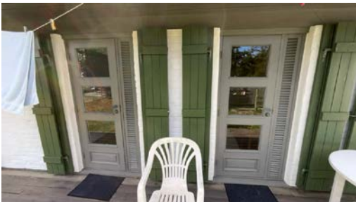
Terrassedører inn til soverom.
