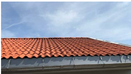
Del av taktekking.
