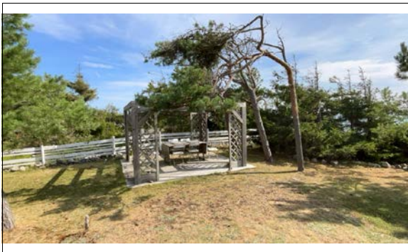
Pergola oppført på eiendommen.
