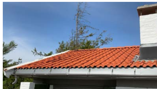
Del av taktekking.
