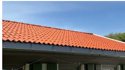
Del av taktekking.
