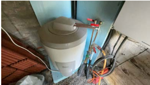
Varmtvannstank.
