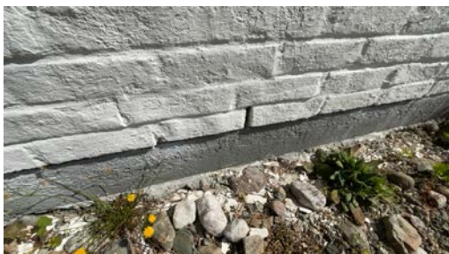
Del av grunnmur - støpt plate på mark.
