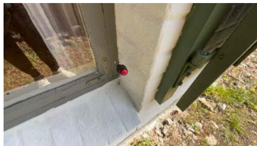
Stikk kontroll på vinduer er utført.
