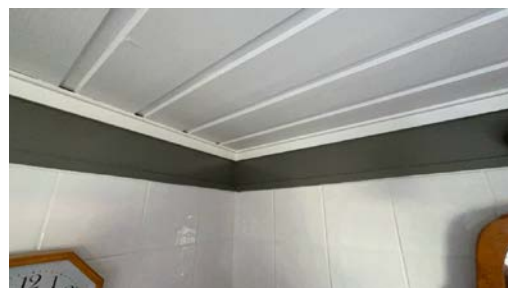
Del av vegg - tak.
