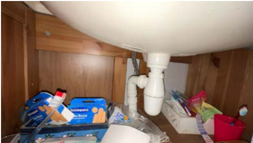
Del av rør til vann.
