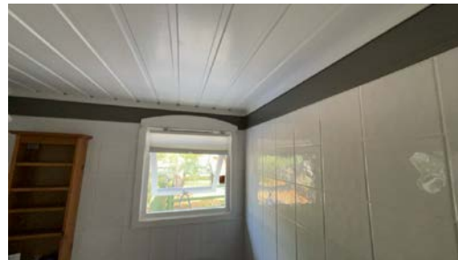
Del av vegg - tak.
