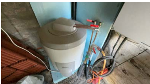
Varmtvannstank.
