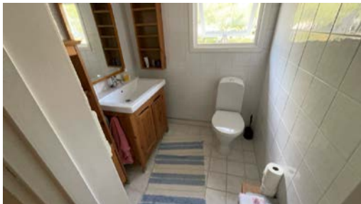
Del av toalettrom.
