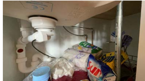
Del av rør til vann.
