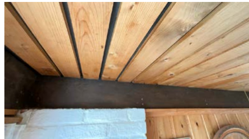
Del av vegg - tak.
