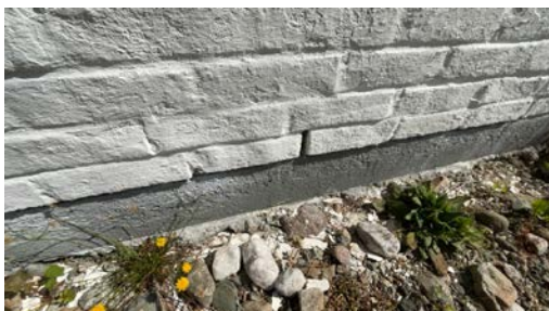
Del av grunnmur - støpt plate på mark.
