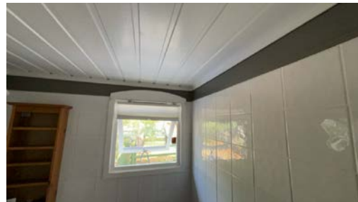
Del av vegg - tak.
