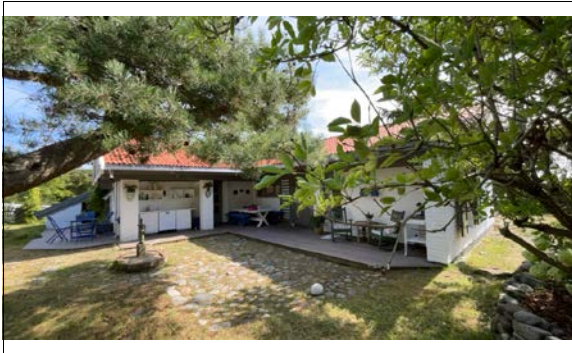
Hovedhytte oppført på eiendommen.
