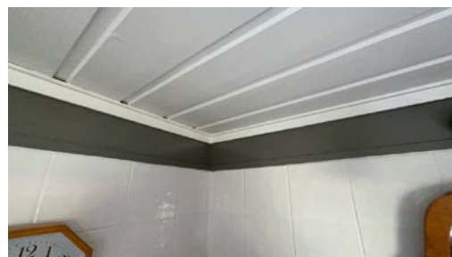
Del av vegg - tak.
