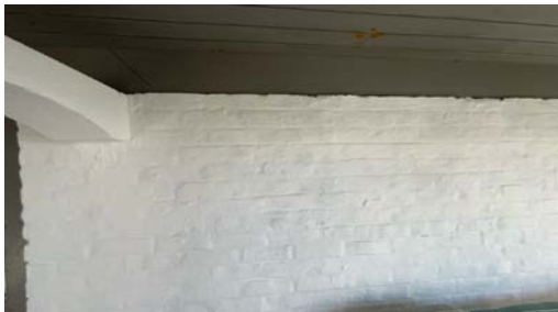
Del av vegg.
