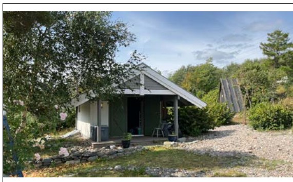
Uthus oppført på eiendommen
