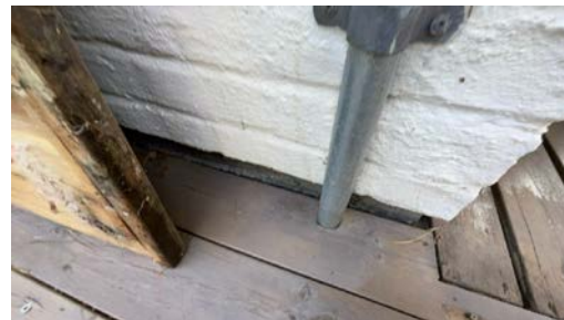
Del av grunnmur - støpt plate på mark.
