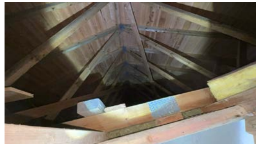
Del av takkonstruksjon, sett fra loft.
