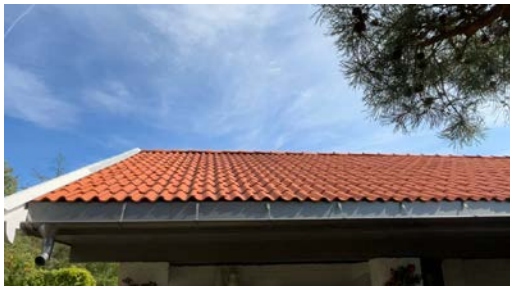
Del av taktekking.
