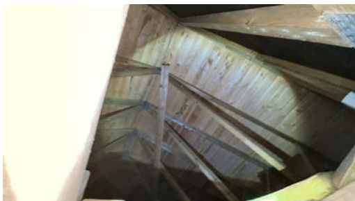
Del av takkonstruksjon, sett fra loft.
