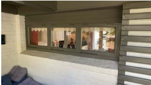
Eksempel på vindu i yttervegg.
