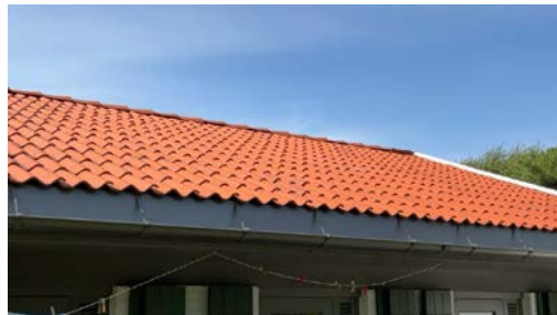
Del av taktekking.
