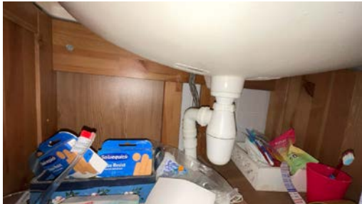
Del av rør til vann.
