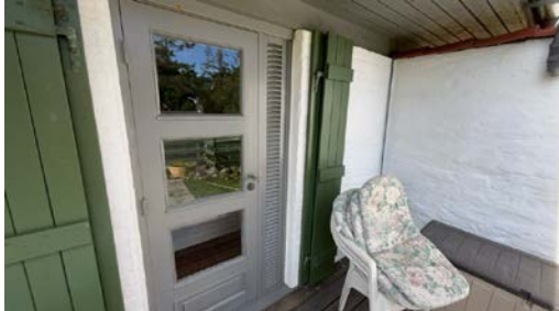
Eksempel på montert ventil i dør felt.
