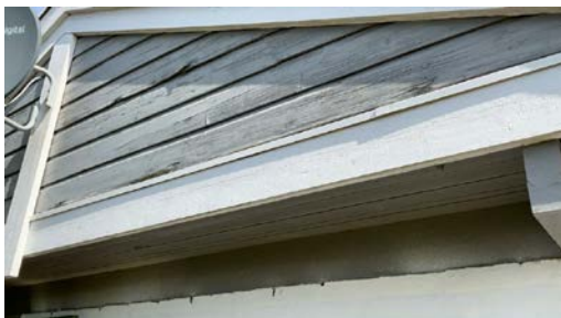
Del av vegg.
