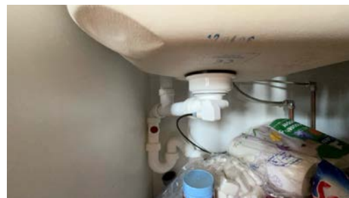
Del av rør til avløp.
