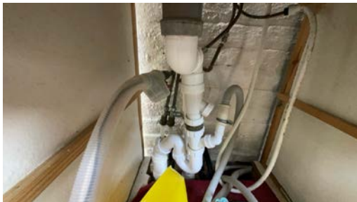
Del av rør til vann.
