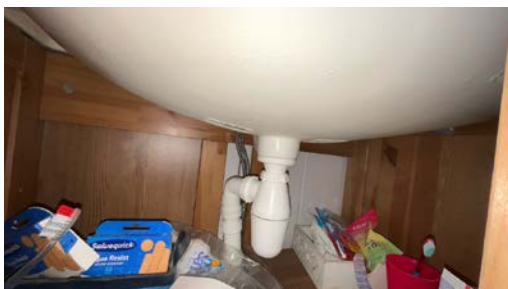
Del av rør til avløp.
