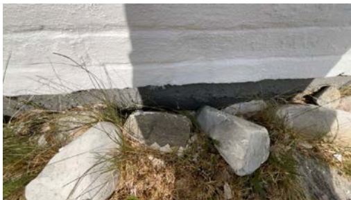
Del av grunnmur - støpt plate på mark.
