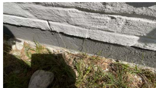
Del av grunnmur - støpt plate på mark.
