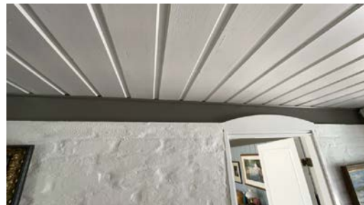
Del av vegg - tak.
