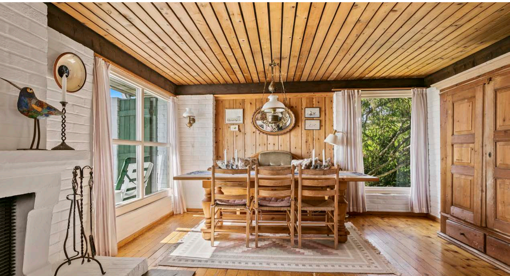
Rommene har furugulv, mur og panel på vegger og panel i himling.
