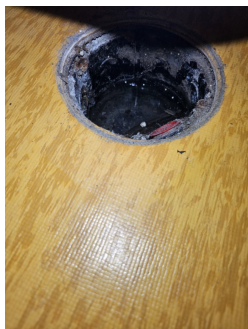
Sluk etter at løs klemring er fjernet.
