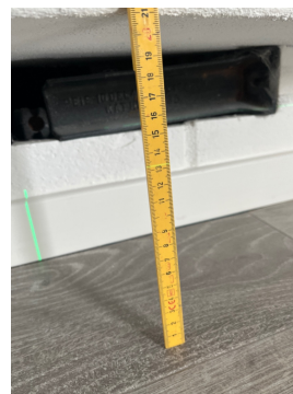
Måling av skjevheter i etasjeskille med retningslaser.
