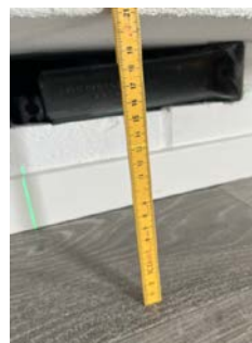
Måling av skjevheter i etasjeskille med retningslaser.
