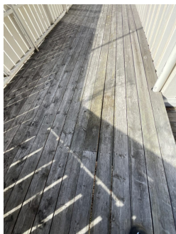
sliytt terrassegulv og skjevhet i rekkverk.
