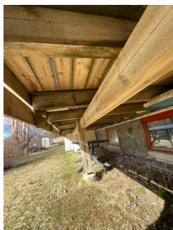
sliytt terrassegulv og skjevhet i rekkverk.
