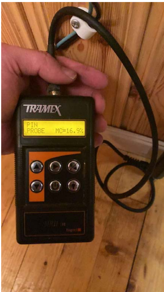
Fuktmåling i oppforet tregulv i kjellerstue viser tegn til forhøyede verdier mot yttervegger.
