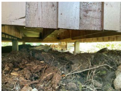
Fundamentering av betongsøyler.
