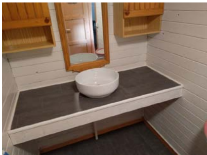
Stellerom med utslagsvask.
