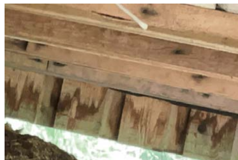
Kledning er stedvis fuktskjoldet på baksiden.
