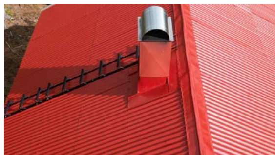
Takstige og heldekkende beslag på pipa.
