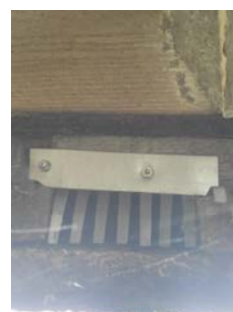
Kledning er stedvis fuktskjoldet på baksiden.
