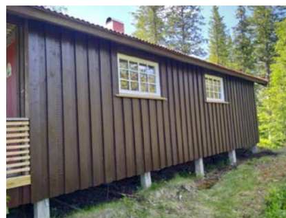
Kontroll av musesperre.
