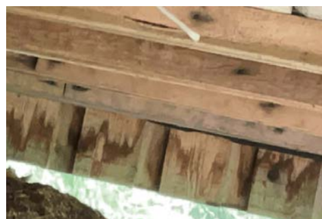
Kledning er stedvis fuktskjoldet på baksiden.
