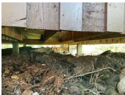
Fundamentering av betongsøyler.
