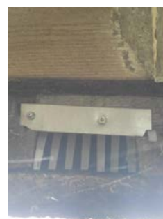
Kledning er stedvis fuktskjoldet på baksiden.
