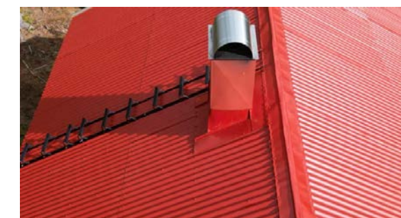
Takstige og heldekkende beslag på pipa.
