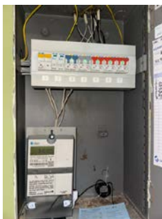
Sikringskap med automatsikringer.
