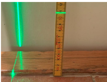
Fallforhold ca. 108 mm overkant gulv ved terskel
