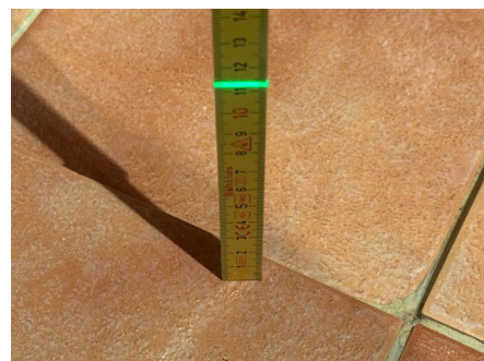
Fallforhold ca. 112 mm overkant gulv ved dusjsone
