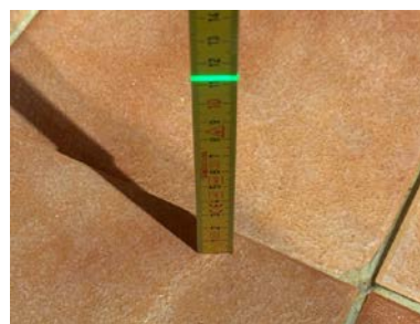
Fallforhold ca. 112 mm overkant gulv ved dusjsone
