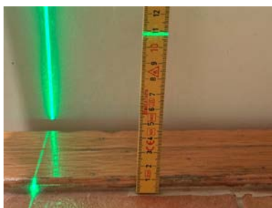
Fallforhold ca. 108 mm overkant gulv ved terskel
