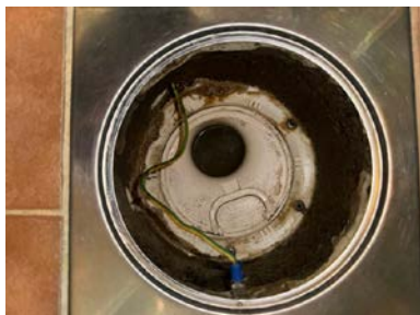
Plastsluk med klemring og synlig membran
