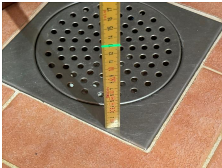
Fallforhold ca. 130 mm topp slukrist i dusjsone
