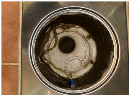
Plastsluk med klemring og synlig membran
