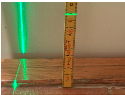
Fallforhold ca. 108 mm overkant gulv ved terskel
